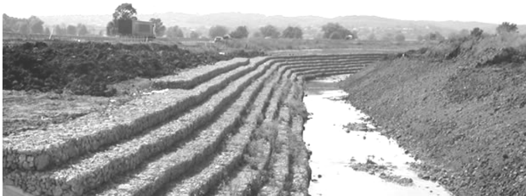
Slika 2.3.1.1: Obaloutvrda od gabiona
