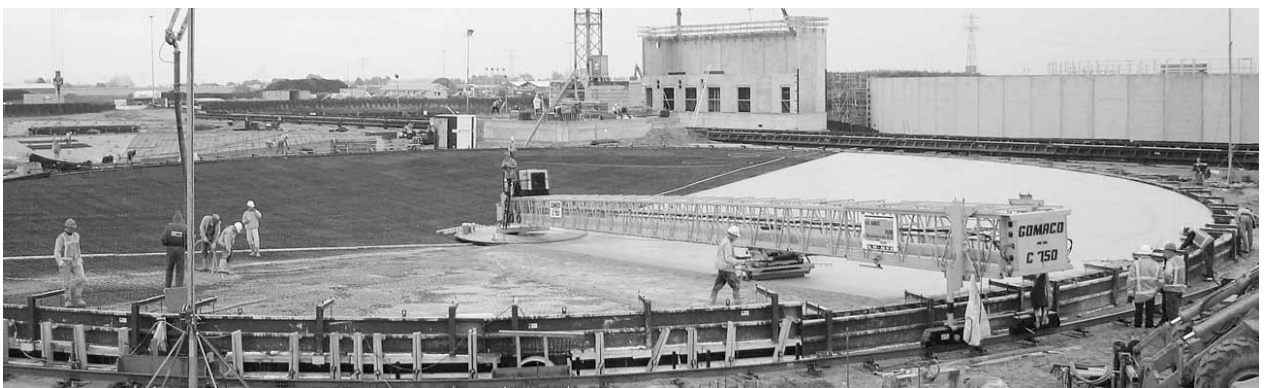
Slika 2.3.2.1.: Izvedba plošne betonske konstrukcije dna nekog spremnika valjanjem betona
