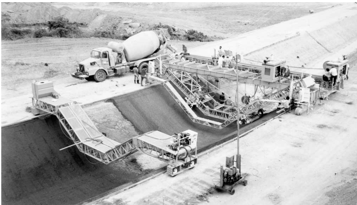
Slika 2.3.2.9: Finišeri za ugradnju betona odnosno za izvedbu plošnih betonskih konstrukcija (gore) i kanalski finišeri za izvedbu betonskih obloga kanala
