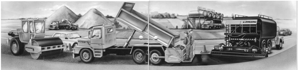
Slika 2.3.3.4: Tehnološki postupak i pripadni strojno-tehnološki sustav odnosno grupa strojeva pri izvedbi kolničke konstrukcije u vidu zasutog makadama odnosno površinske obrade (kamion s spremnikom i razastiračem veziva, razastirač kamene sitneži pogonjen kamionom kiperom koji dovozi sitnež, samohodni vibracijski valjak)
