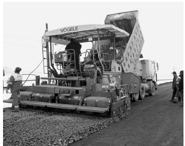
Slika 2.3.3.3: Finišer za asfalterske radove
