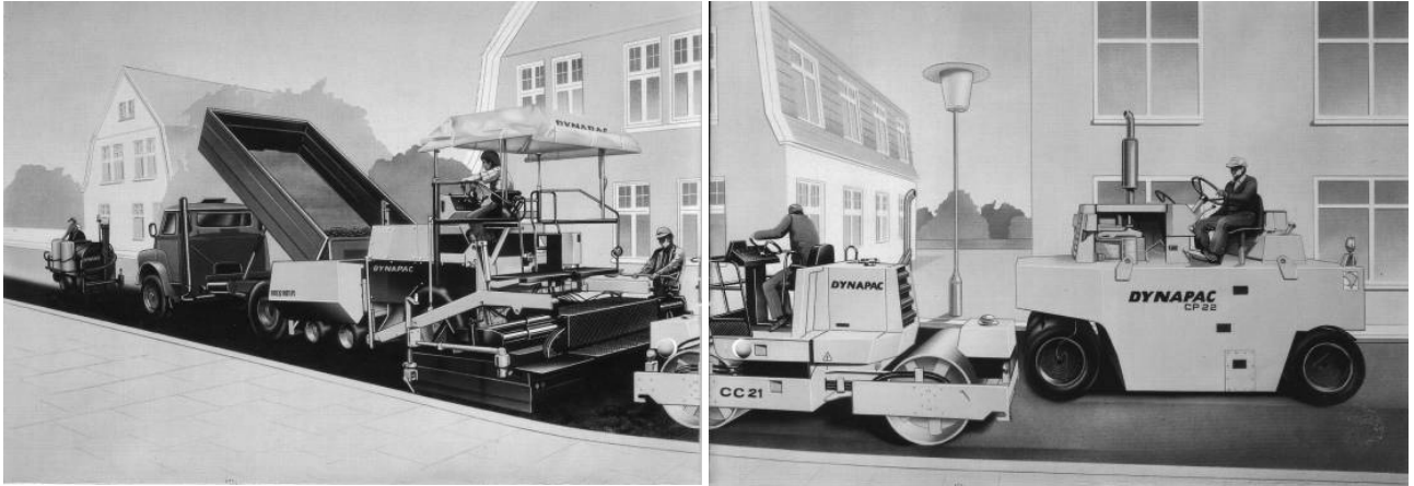
Slika 2.3.3.2: Tehnološki postupak i pripadni strojno-tehnološki sustav odnosno grupa strojeva pri ugradnji asfaltne kolničke konstrukcije od vruće miješanih valjanih asfaltnih betona (kamion kiper, finišer za ugradnju asfaltbetona, tandem-vibracijski valjak, valjak gumenjak)
