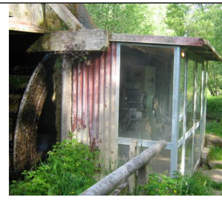
Vodno kolo u primjeni danas, mala hidroelektrana u Bavarskoj instalirane snage cca 40kW
