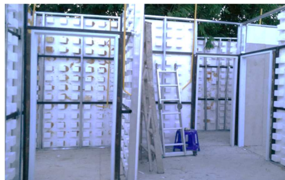
(d) Installation of M&E system
