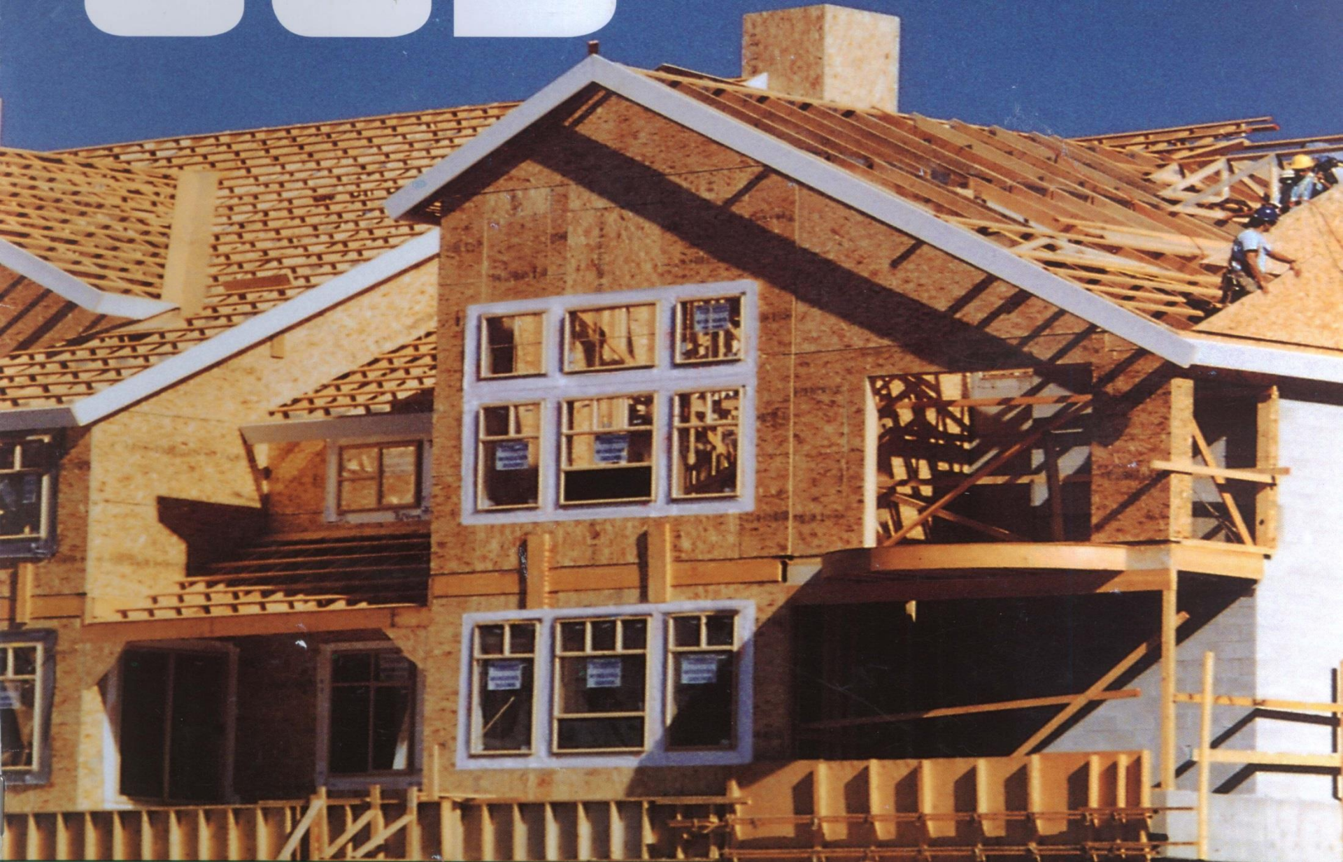
OSB ploče kao obloga i vertikalna oplata okvirne konstrukcije drvenih kuća (Kanada)
