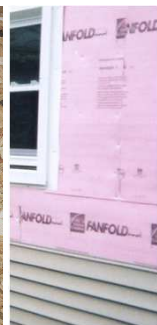
Ploče izolacije i vanjska obloga
