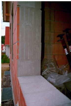
Primjer dobro pripremljenih špaleta
