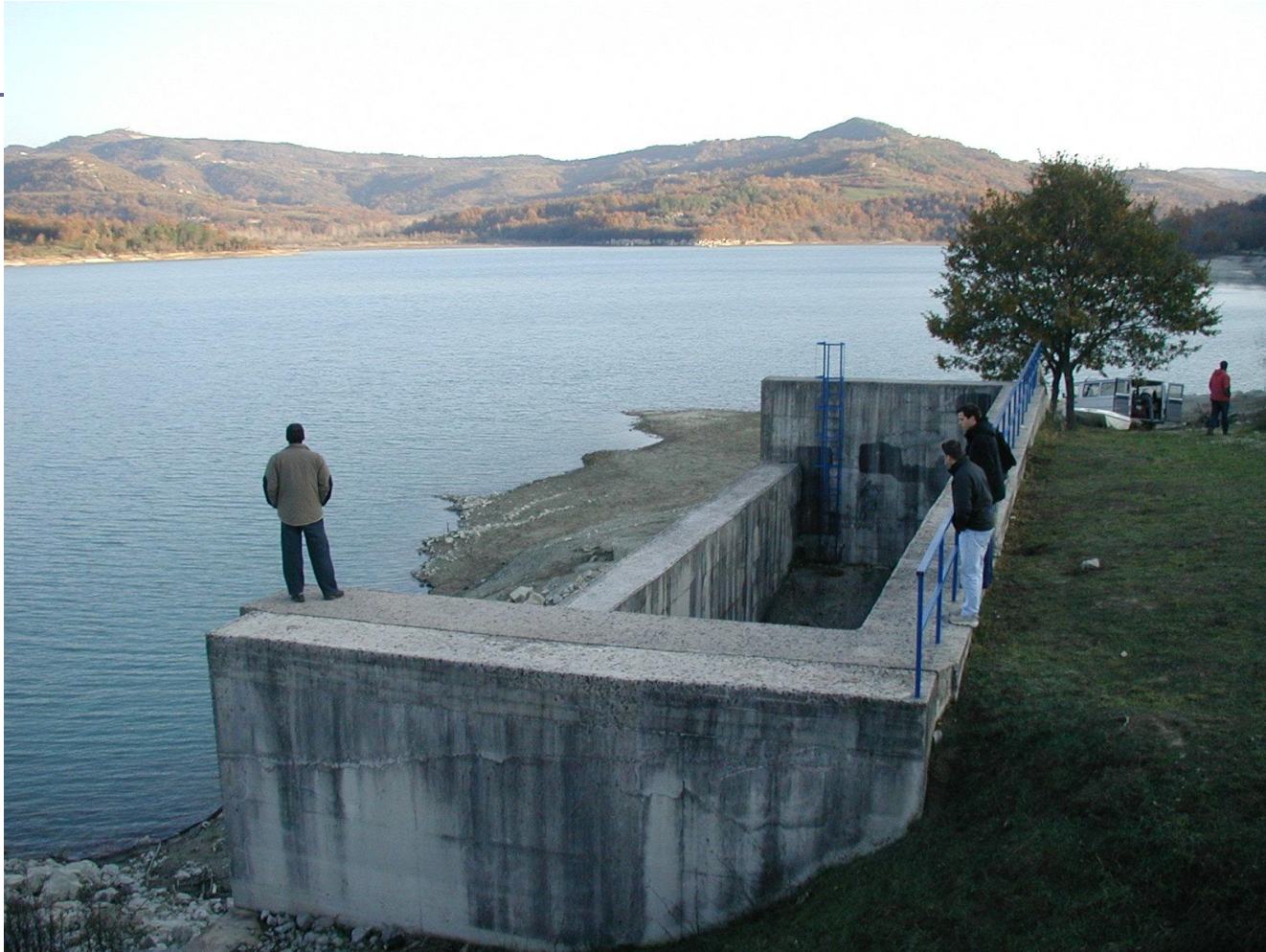
Bočni preljev sa sabirnim kanalom (Botoniga)
