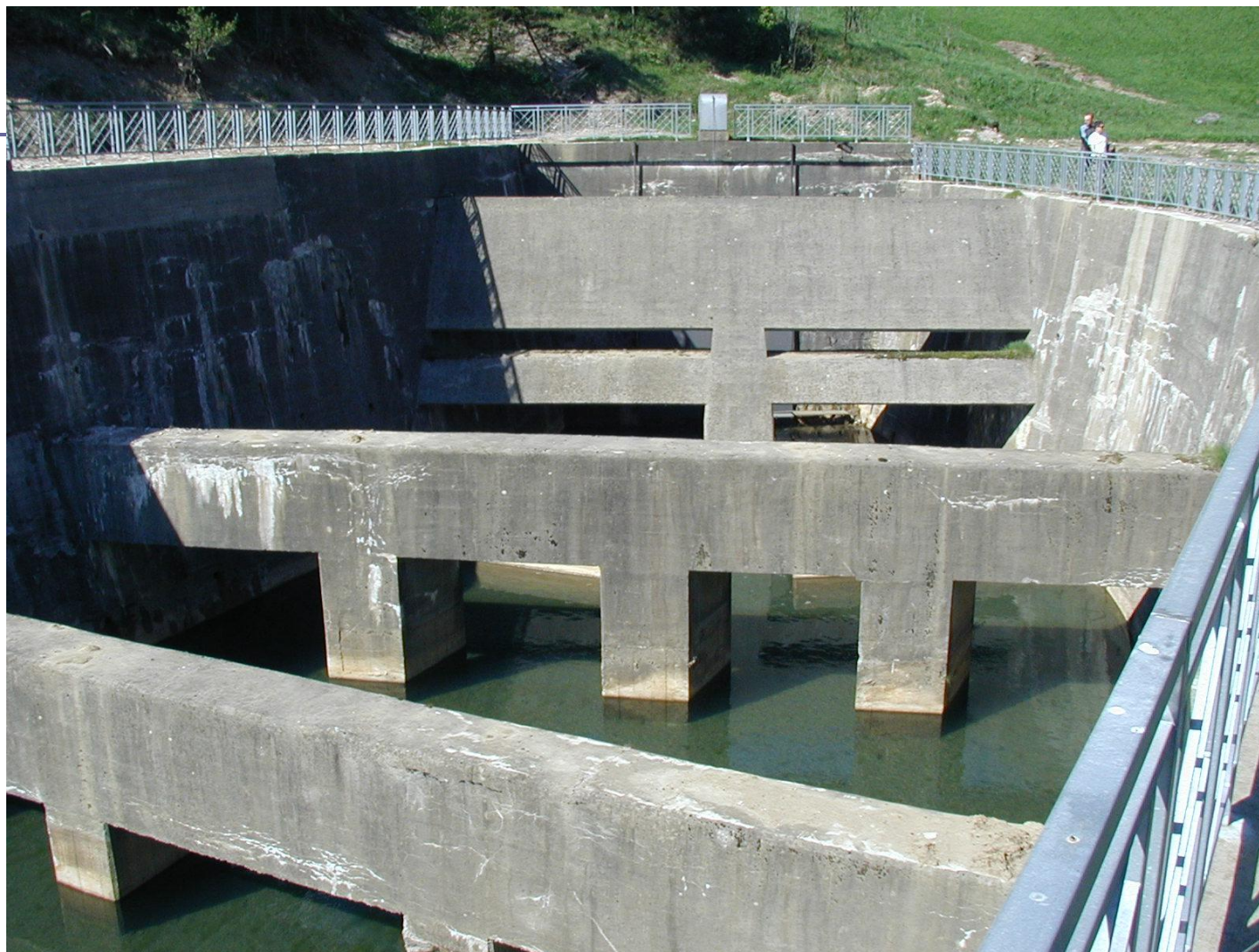
Slapište temeljnog ispusta i bunarskog preljeva -Lokvarsko jezero
