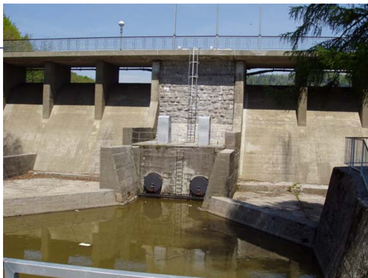
Više povezanih slapišta (u kaskadama) akumulacija Bajer - Fužine
