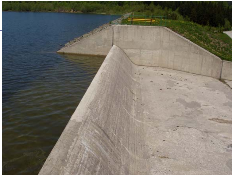
Preljev praktičnog profila (Lepenica), oštećenja preljeva i brzotoka
