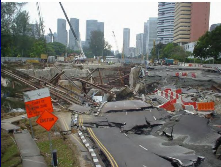
Kolaps prolaza ispod autoceste u Singapuru („cut and cover” sistem) , 2004
