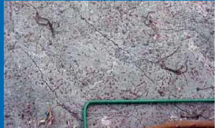
Primjer pojave termičkih pukotina na površini temelja
