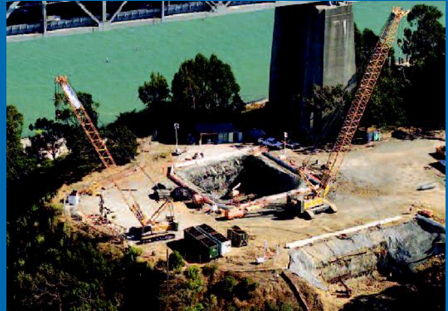
Primjena masivnog betona za temelje stupova mosta
