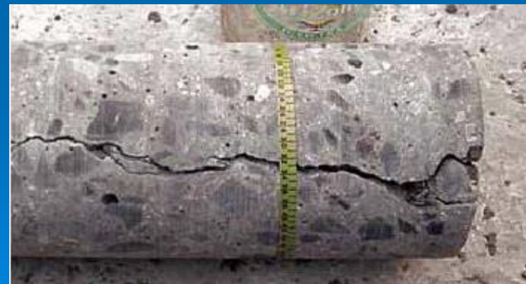
Termičke pukotine na valjku izbušenom iz temelja
