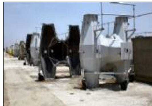
Slika 4 Oplata betonskog bloka (Core-loc)
