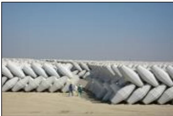
Slika 3 Skladištenje blokova (Core-loc)
