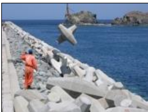
Slika 5 Postavljanje betonskih blokova (Core-loc)
