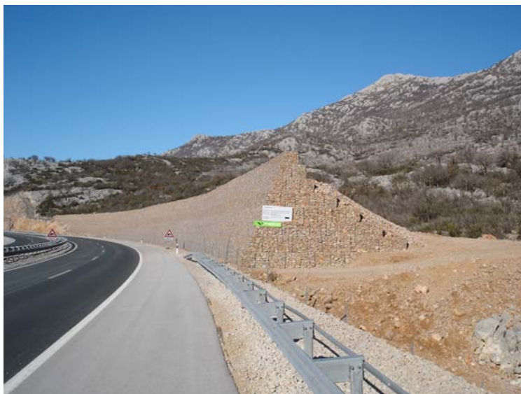
Slika 8.16 Probna dionica vjetrobrana izgrađenog kao nasip na autocesti A1
