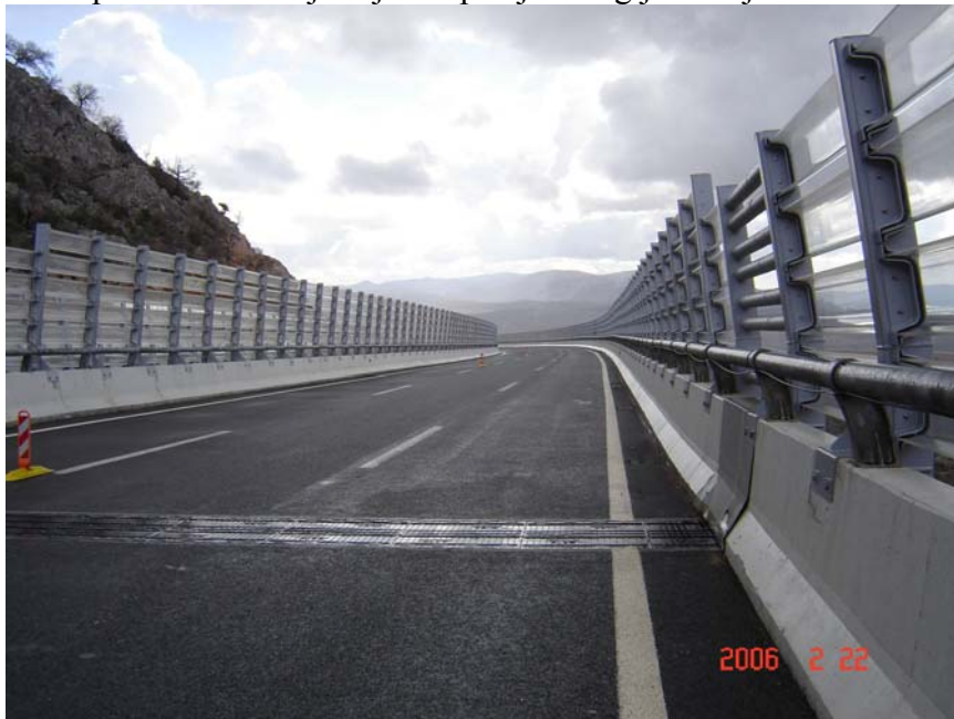
Slika 8.18 Vjetrombrani na viaduktu Baričevići
