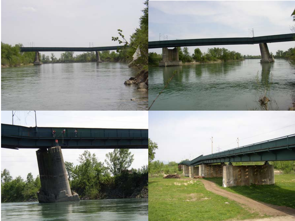
Slika 4.8 Havarija mosta Jakuševac
