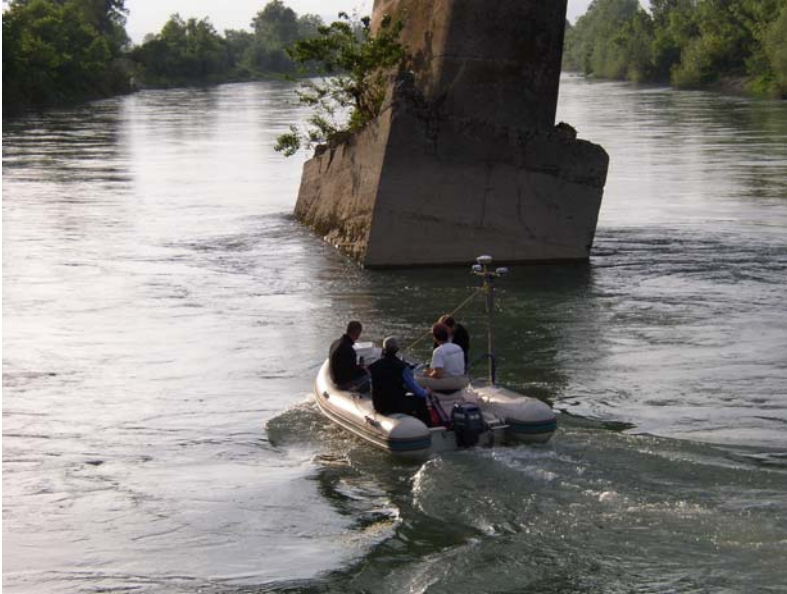
Slika 4.10 Hidrografska mjerenja na području stupa mosta Jakuševac
