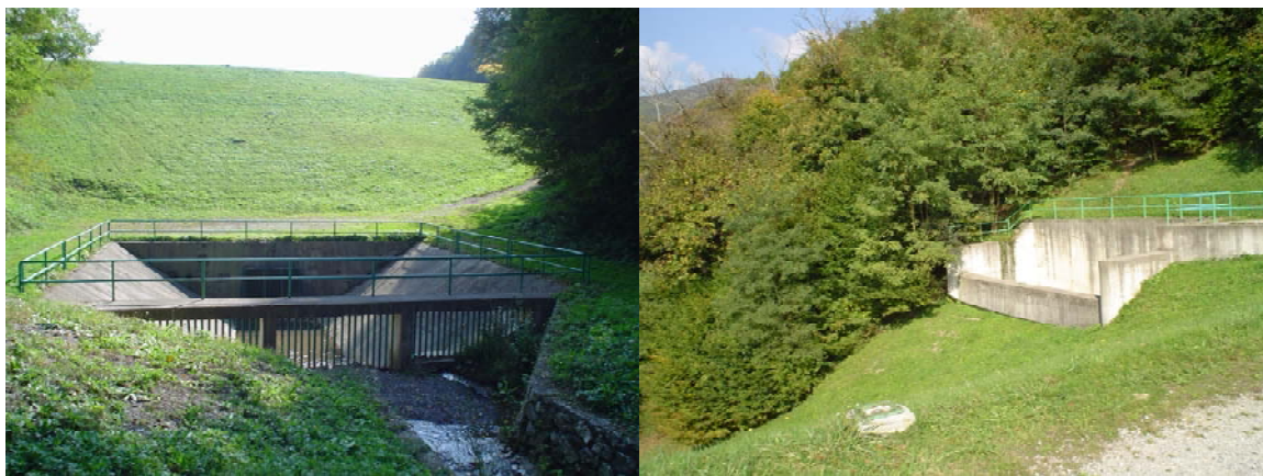
Slika 3.13 Ulaz u temeljni ispust i bočni preljev brane Lagvić
