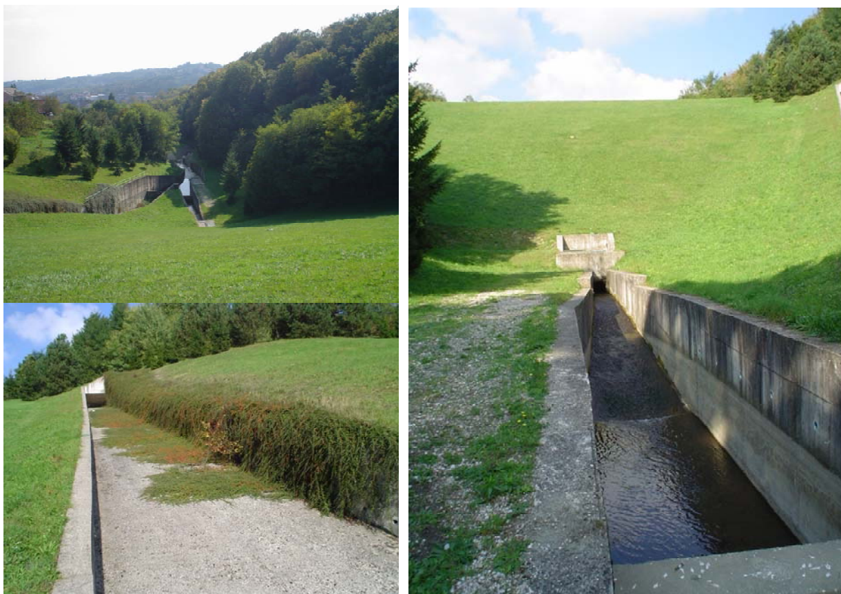
Slika 3.14 Nizvodna strana brane, brzotoci bočnog preljeva i temeljnog ispista brane Lagvić
