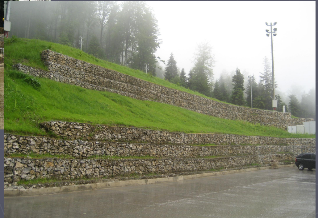
Sustav Terramesh armirano tlo s gabionskom fasadom
