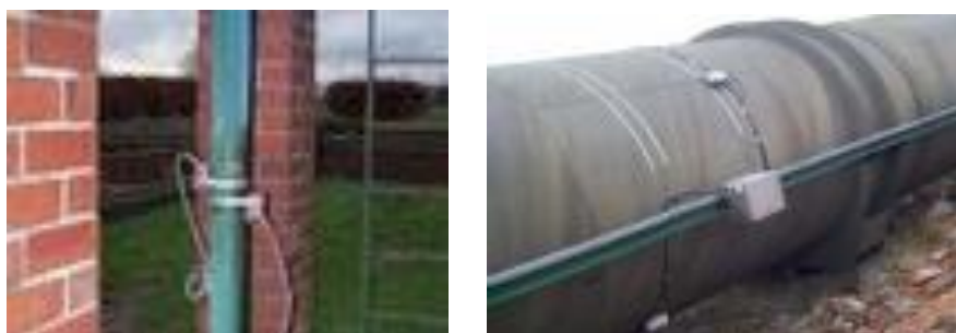
Slika 4.4.:23 Ultrazvučni mjerači ugrađeni na cijevi
