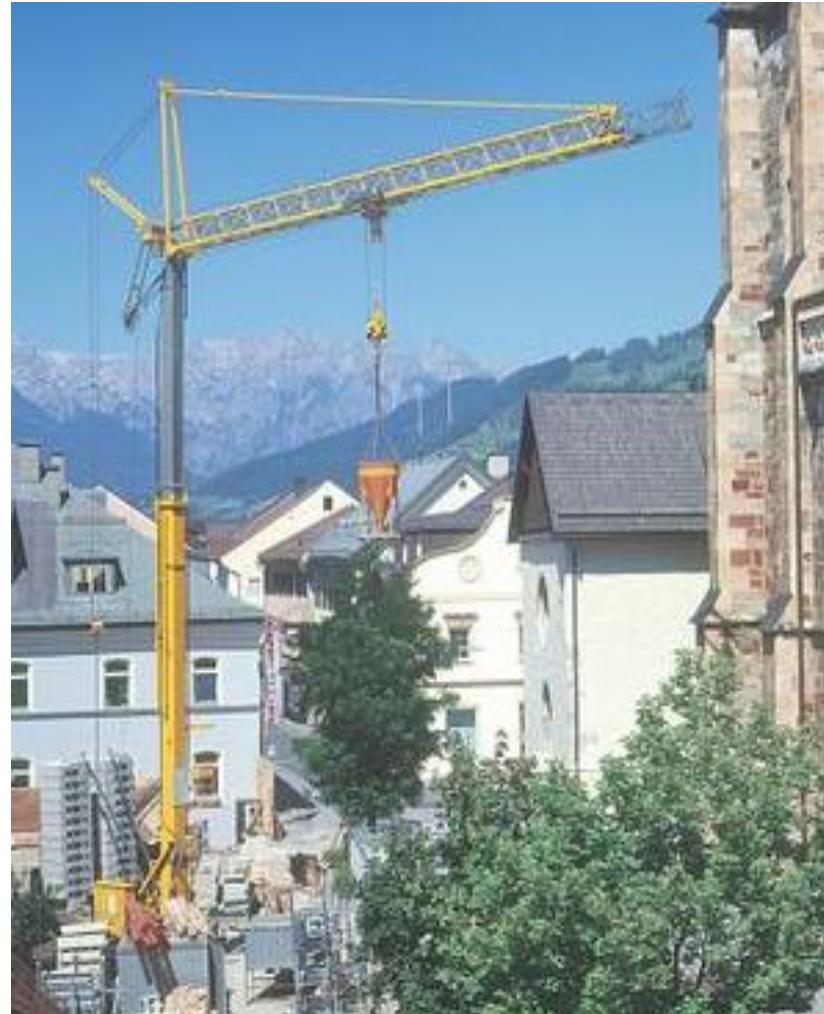
**toranjske dizalice s teleskopskim (provlačnim) okretnim tornjem i s lomljivom kosom granom (lijevo) i teleskopskom zakošenom granom (desno)**
