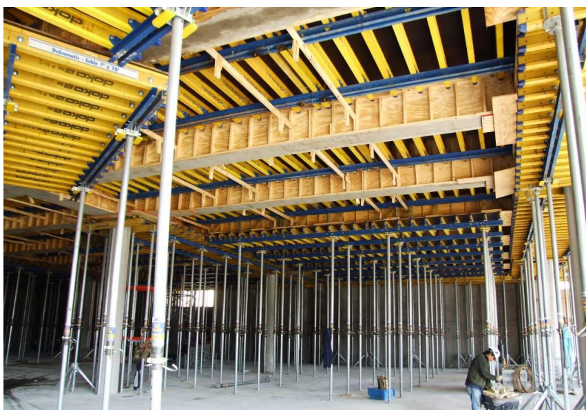
Slika 9-7 – Ploča s gredama u fazi izvedbe
