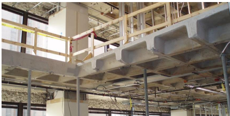
Slika 9-6 – Kasetirana ploča kao betonska međukatna konstrukcija
