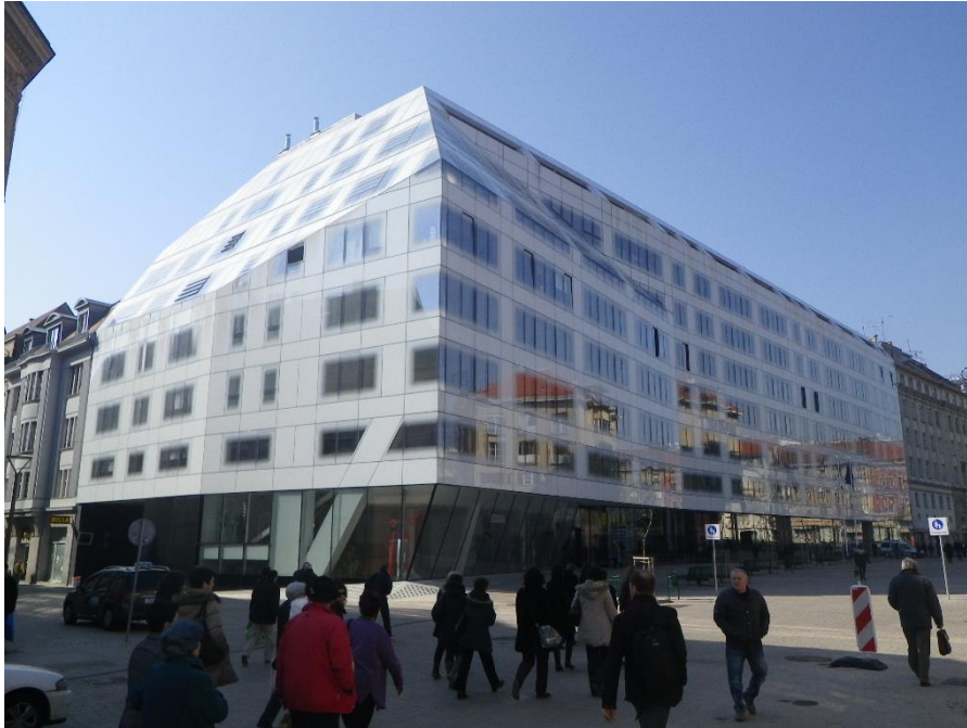
Slika 10-3 Fasada suvremene zgrade u povijesnom središtu Zagreba, načinjena od staklenih panela.
