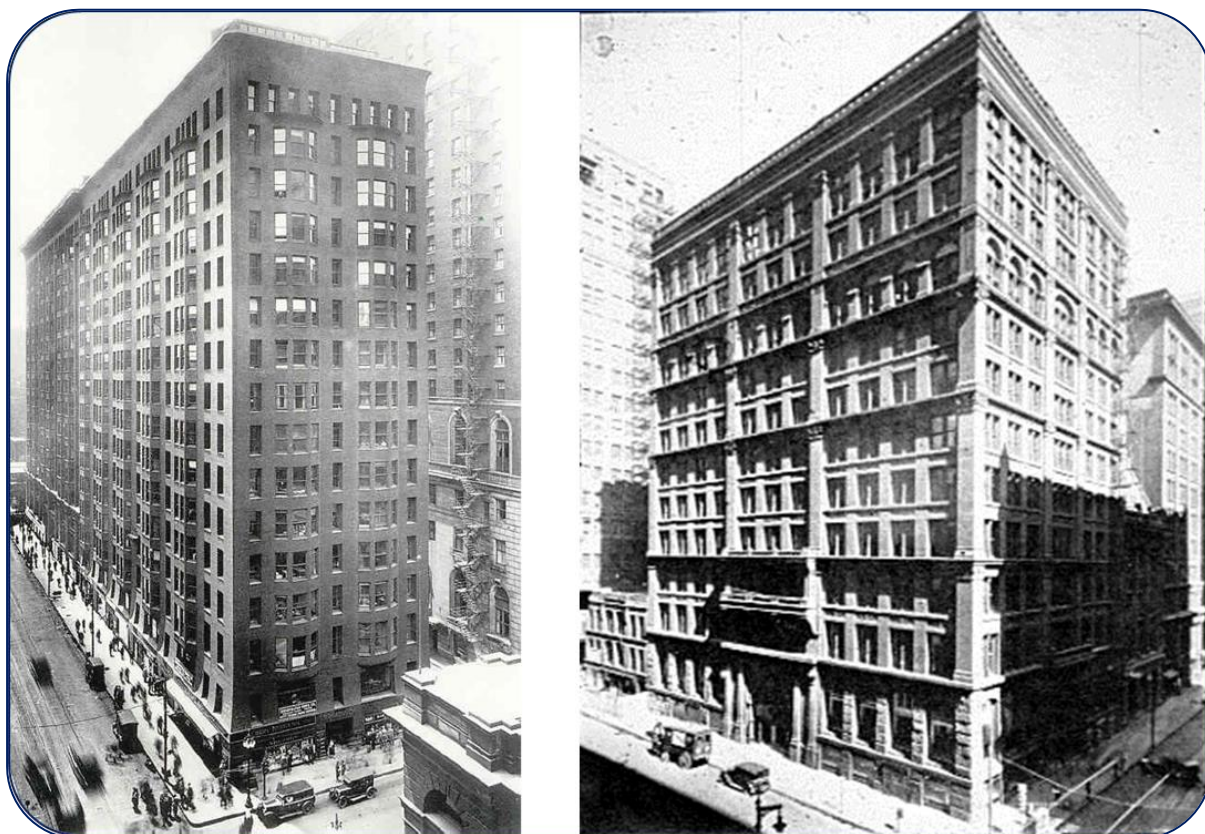
Slika 4-1 – Usporedba: okvirna zgrada Home Insurance Building 1885. (desno) [1] i prava masivna zgrada Monadnock Building 1891. (lijevo) [2]
