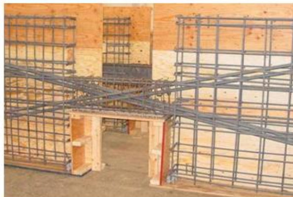
Dijagonalno armirana spojna greda
