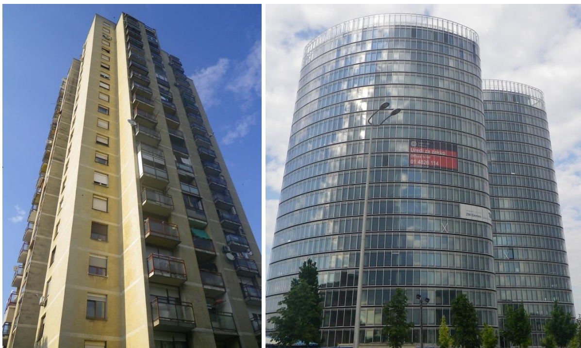
Slika 2-3 – Primjeri zagrebačkih nebodera: lijevo – stambeni toranj na Prisavlju s posmičnim zidovima, desno – poslovni toranj okvirnog sklopa s jezgrom na Zagrebačkoj aveniji
