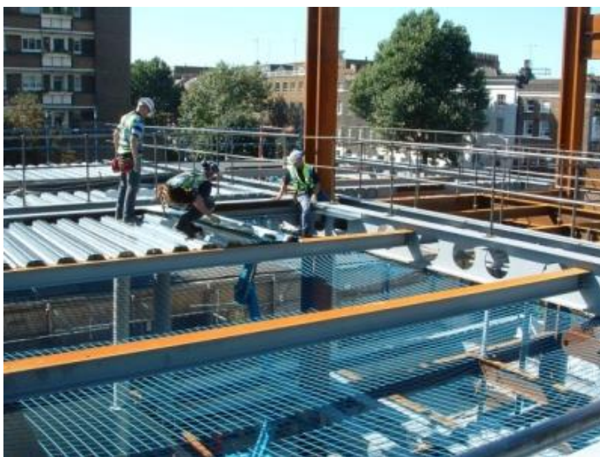
Slika 9-8 – Elementi čelične međukatne konstrukcije: glavni nosači tvore glavni nosivi sustav, između njih su sekundarni nosači koji podupiru profilirani lim, na kojemu se izvodi betonska stropna ploča.
