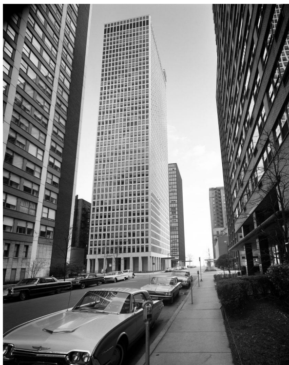
Slika 1-7 – Neboder Chestnut-Dewitt, prva zgrada konstruirana kao cijevni sustav – Chicago, 1965. [4]
