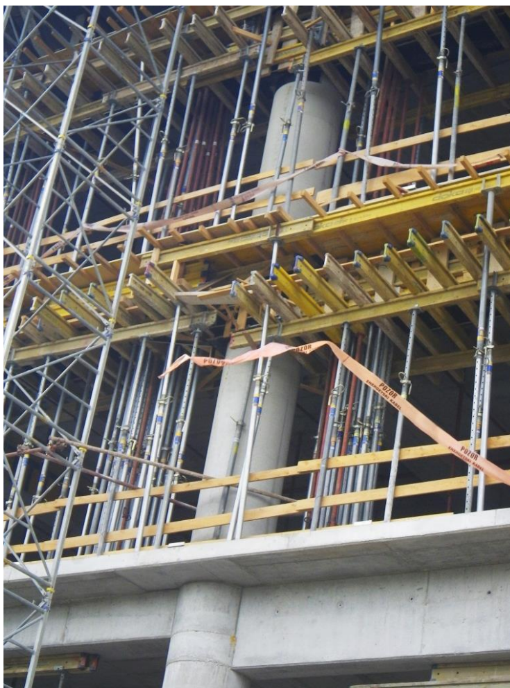
Slika 2-4 – Detalj izvedbe poslovne zgrade od armiranog betona – skela i oplata.
