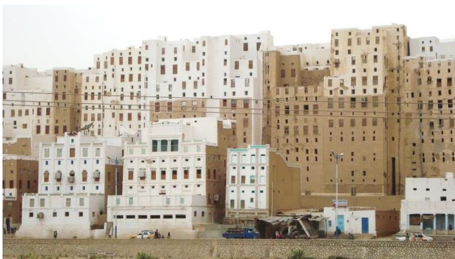
Slika 1-3 – Višekatnice od nepečene opeke – grad Shibam, Jemen, 16. stoljeće. [6]
