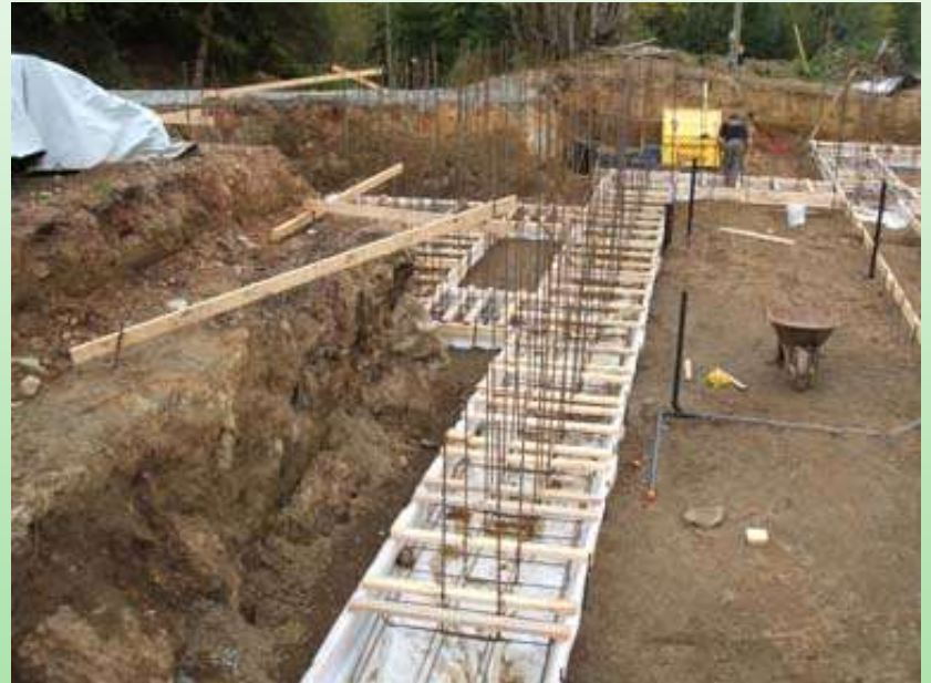
Slika 4-2 Temelj samac (lijevo) i temeljna traka (desno)
