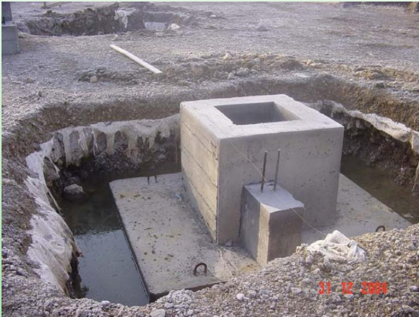
Slika 4-2 Temelj samac (lijevo) i temeljna traka (desno)
