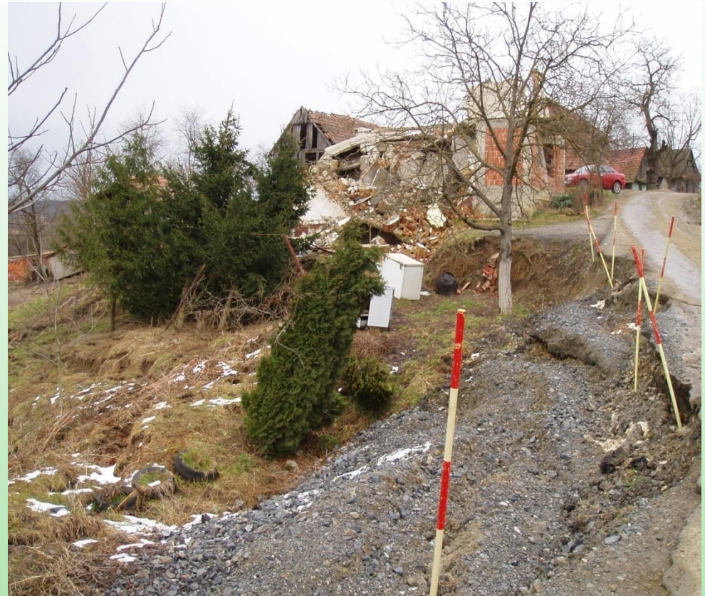
fotografija gornjeg dijela klizišta u zoni prometnice
