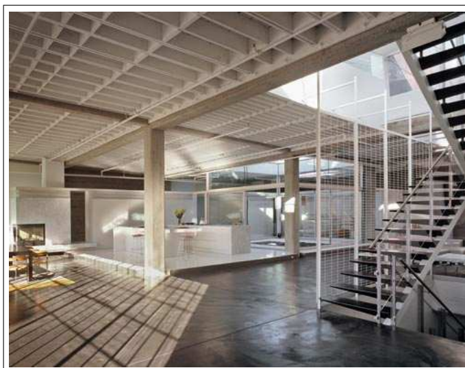
Slika 274.: Suvremena međukatna konstrukcija u obliku roštilja (izvor: http://www.nikiomahe.com/architecture-design/ )
