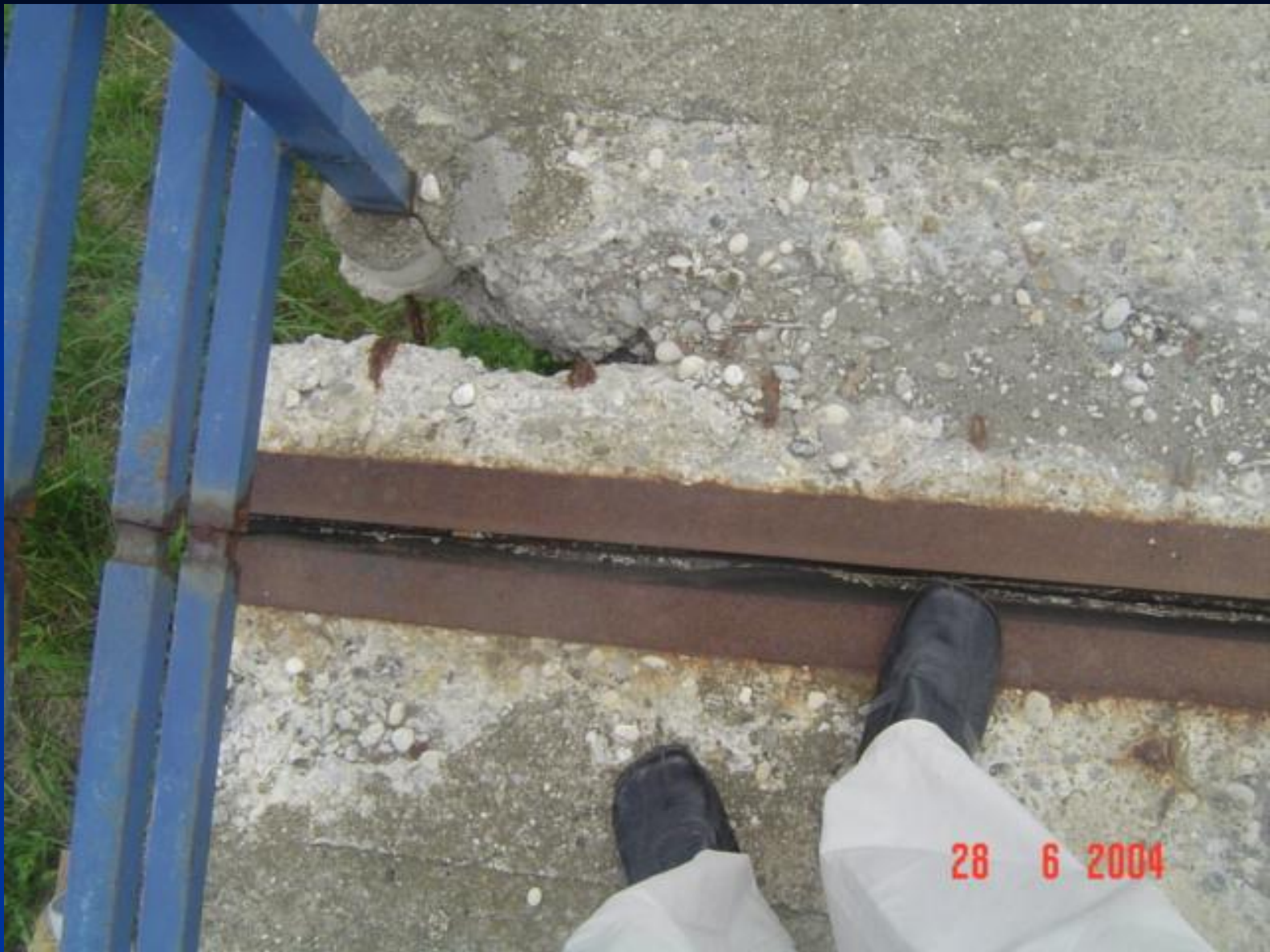
Pogled na dilataciju
