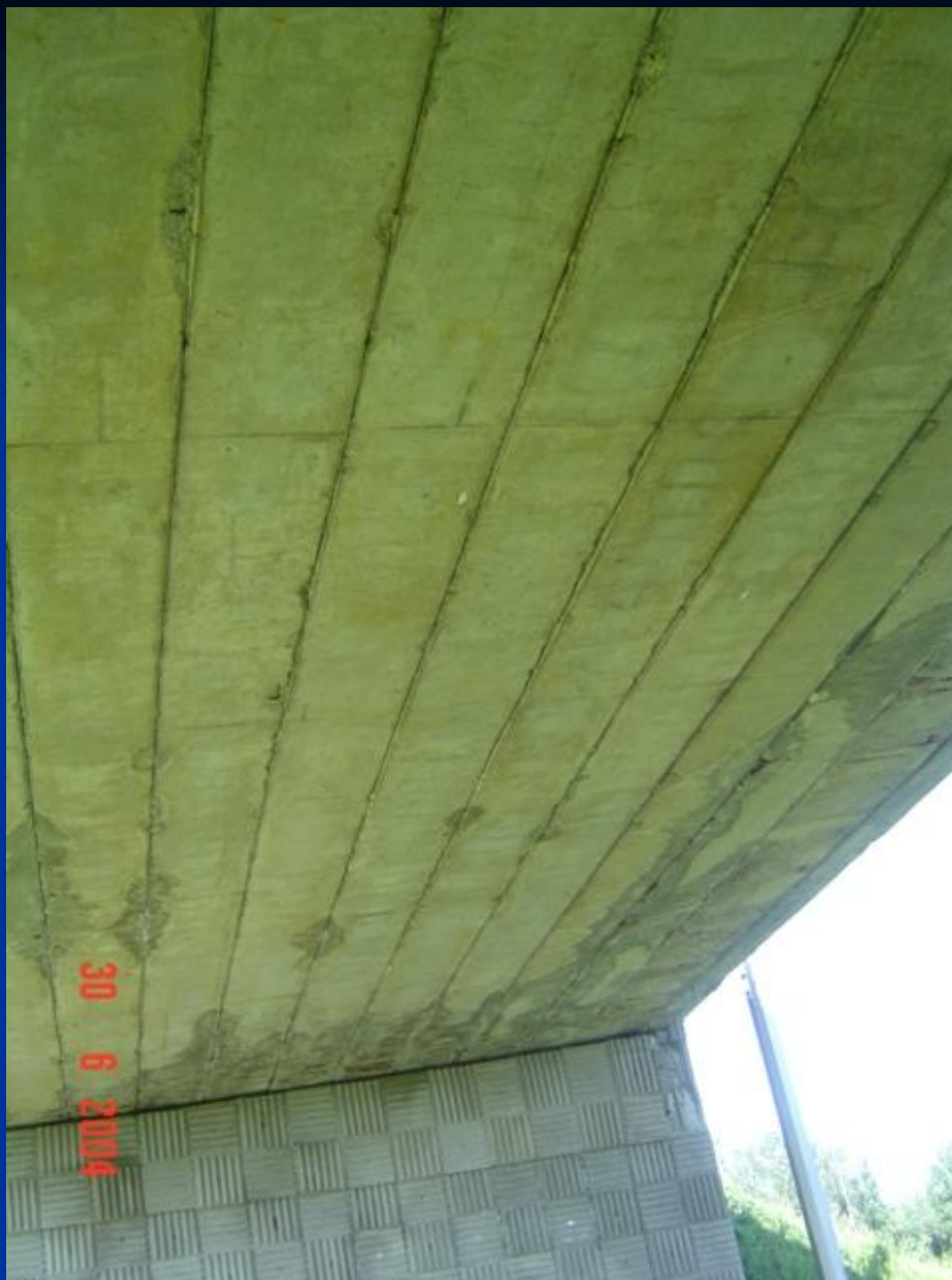
Podgled rasponske konstrukcije
