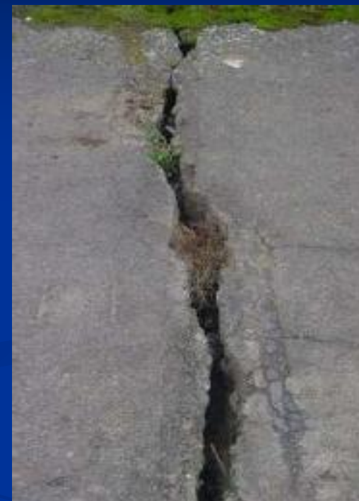
Poprečna reška iznad oslonca nadvožnjaka
