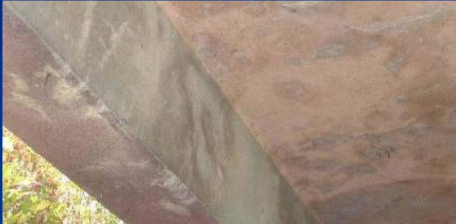
Procjeđivanje i kristalizacija na spoju ploče s nosačima
