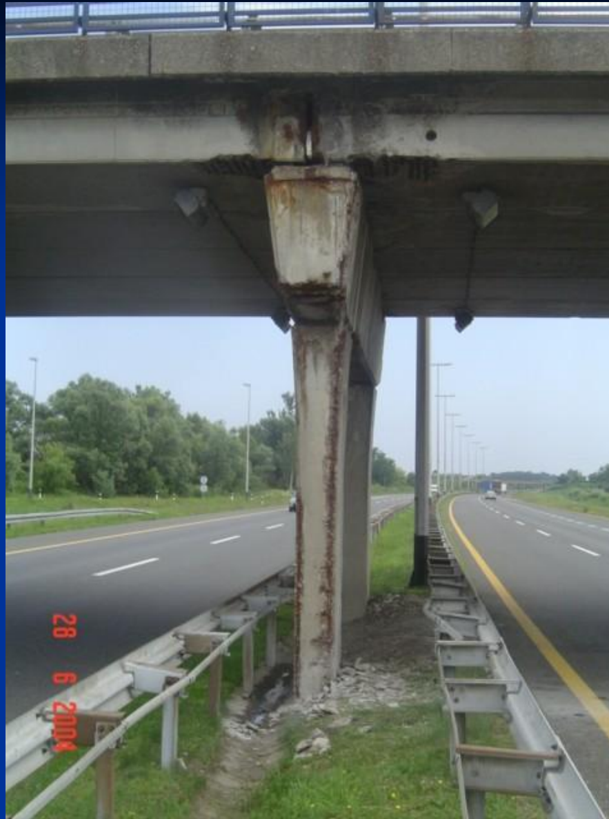
Pogled na stupašte nadvožnjaka u razdjelnom pojasu autoceste
