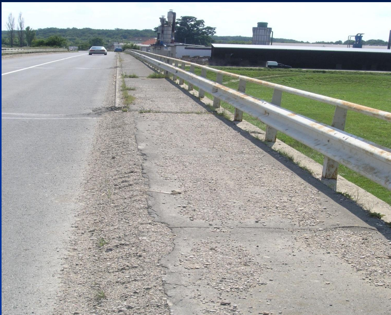
Pogled na pješačku stazu i ogradu nadvožnjaka
