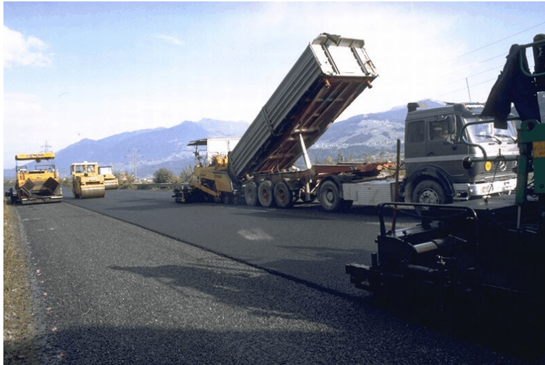
Abb.16.3 Die Endphase im Straßenbau
