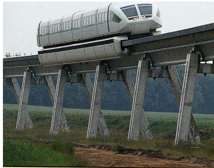
Abb. 1.4. Der Transrapid schwebt über ein Schienenband auf Stelzen
