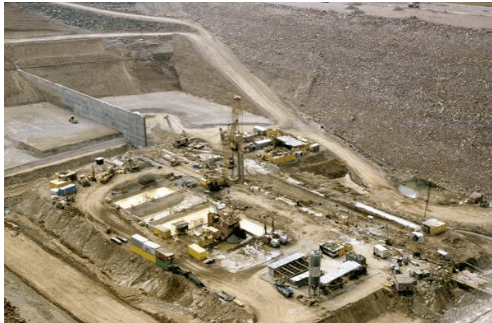
Abb. 13.3. Die Baustelle des Xiaolangdi Damms
