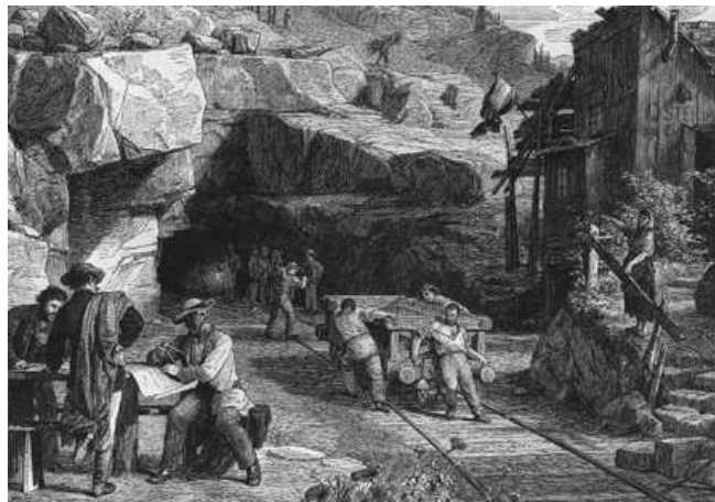
Abb. 15.3. Konstruktion des St. Gotthard Tunnels, Schweiz
