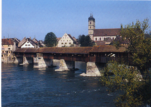
Abb. 9.1. Die überdachte hölzerne Säckinger Brücke über den Rhein
