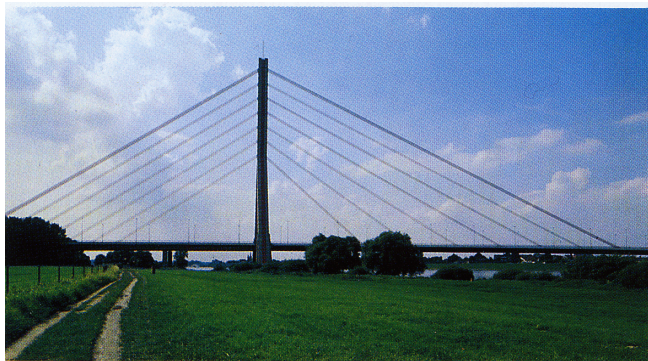
Abb. 9.4. Die Autobahnbrücke bei Düsseldorf
