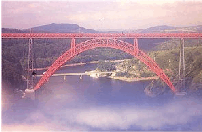
Abb. 4.5. Das Garabit-Viadukt in Südfrankreich
