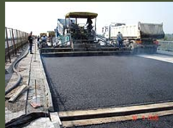
Izvedba kolničkog zastora
