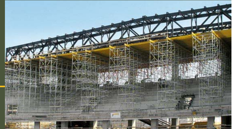
Sportska arena Lora, Split, Hrvatska Montaža stropne konstrukcije
