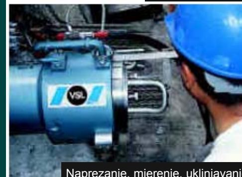
Naprezanje, mjerenje, uklinjavanje
