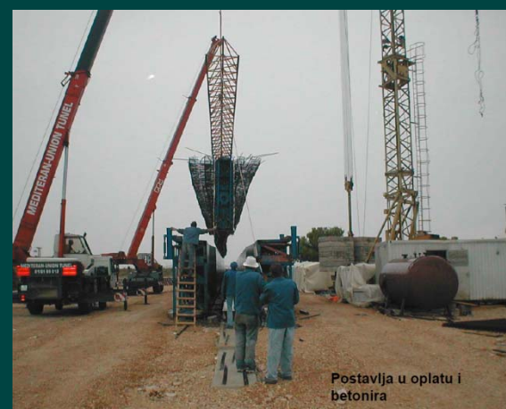
Kroz armaturni koš se provlače fleksibilne cijevi kroz koje će se uvući kablovi
