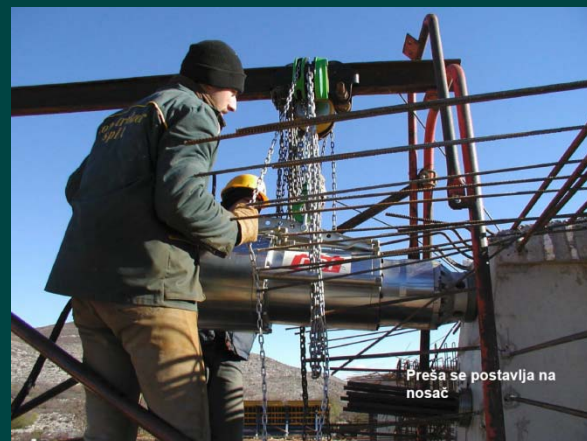
Na užad se montiraju sidrene glave
