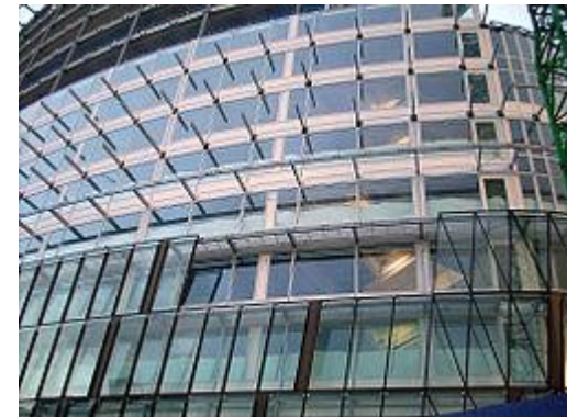
Dvostruka fasada: dvije površine između kojih cirkulira zrak, razmak 20 cm do 2 m
