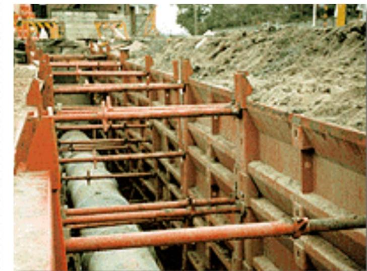
Tehnološki (radni) poprečni presjek rova sa cijevi kod iskopa u sljevljenom tlu (lijenku zastivljenoj vodom):
