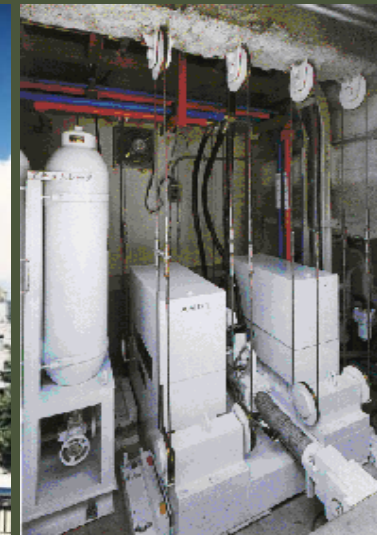
Kyobashi Seiwa, Tokyo, Japan; zgrada s 11 katova, visine 33,1 m; aktivni prigušivač mase
