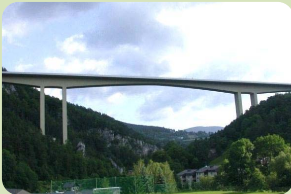
Most Schottwien, Austrija 1991. god, razmak stupova = 20,5 m
