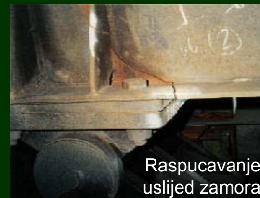
Oštećenja od potresa
