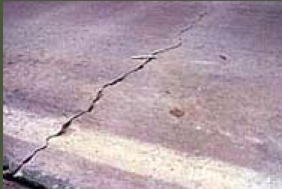
Pukotine u betonu uslijed promjena temperature
