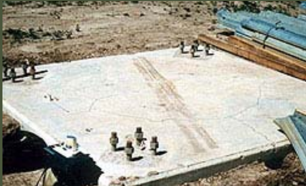
Pukotine u betonu uslijed promjena temperature
