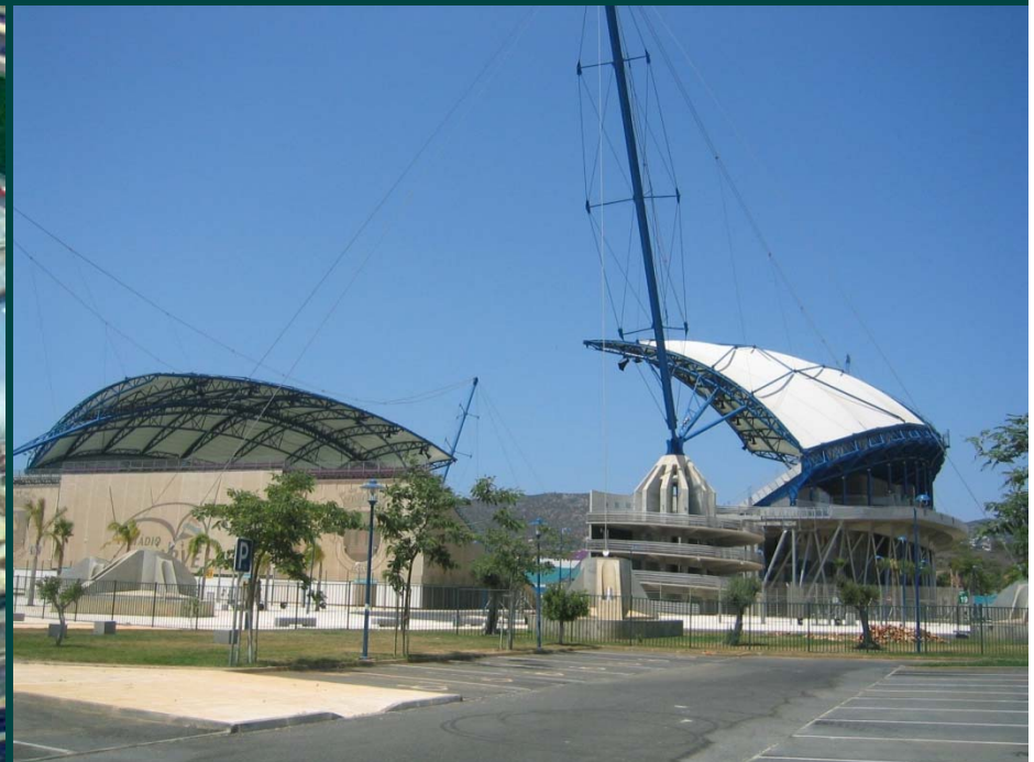
Estadio Algarve, Algarve, Portugal (2004), membrana ovješena kabelima na jarbole
