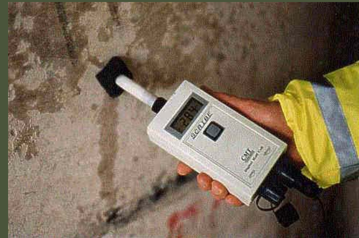
Mjerenje potencijala korozije armature
