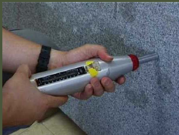
Mjerenje čvrstoće sklerometrom
