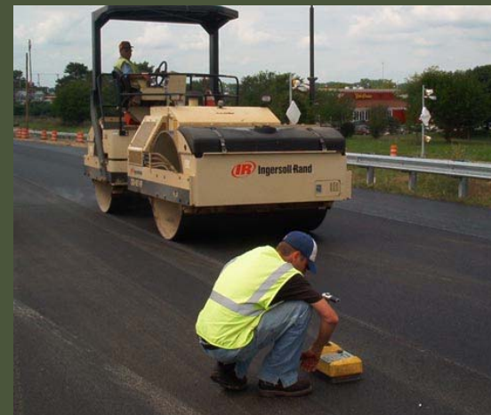
Određivanje gustoće nuklearnim mjerilom
