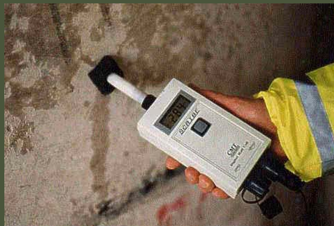
Mjerenje potencijala korozije armature
