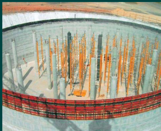
Podupirači za izvedbu krovne ploče
