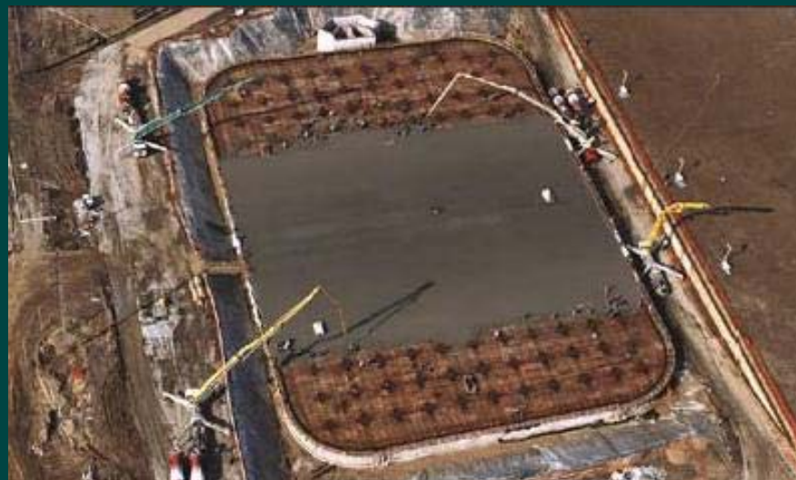
Izvedba prednapete krovne konstrukcije
