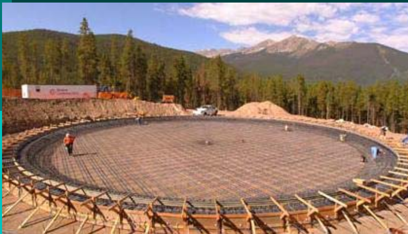
Prednapeta temeljna ploča
