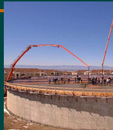
Izvedba prednapete krovne konstrukcije
