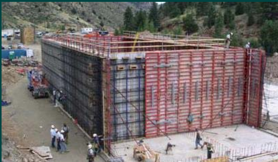
Oplata zidova vodospremnika
