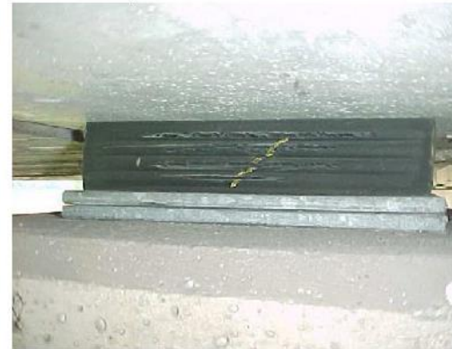
ELASTOMERLAGER RISSIG
