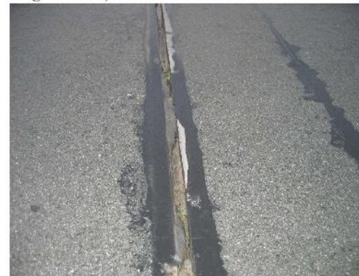
FUGENSPALT VERSCHMUTZT
