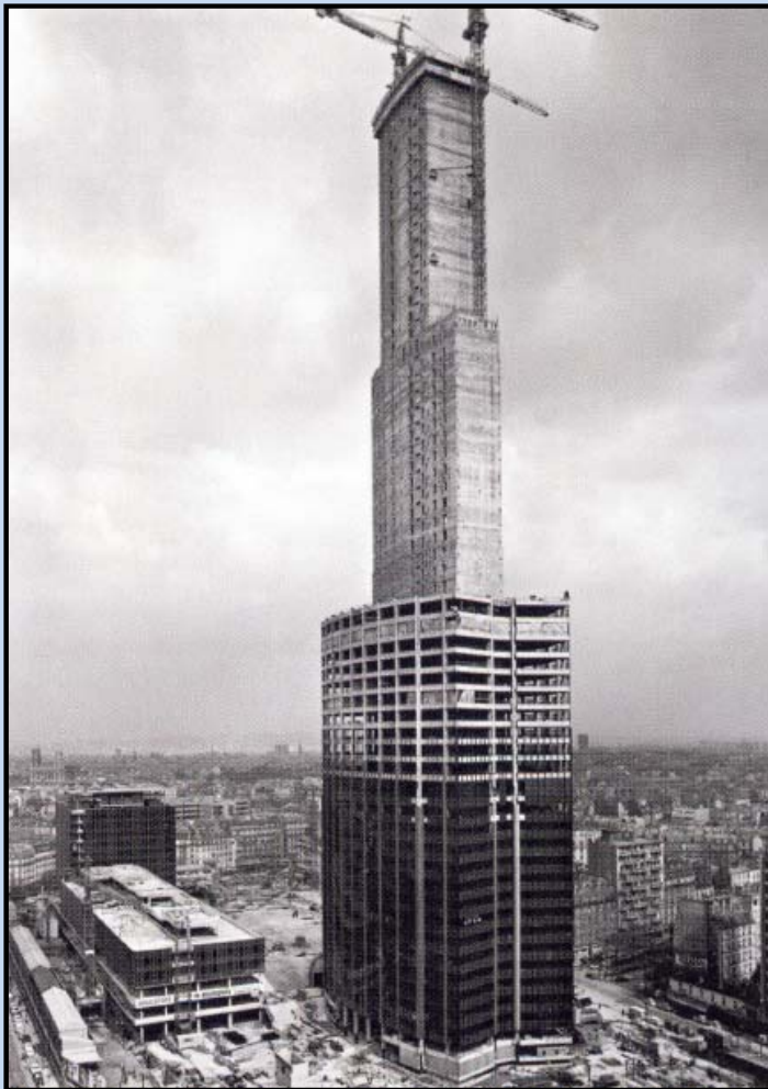
Fotografija izvedbe pokazuje zidove koji oblikuju servisnu jezgru.
