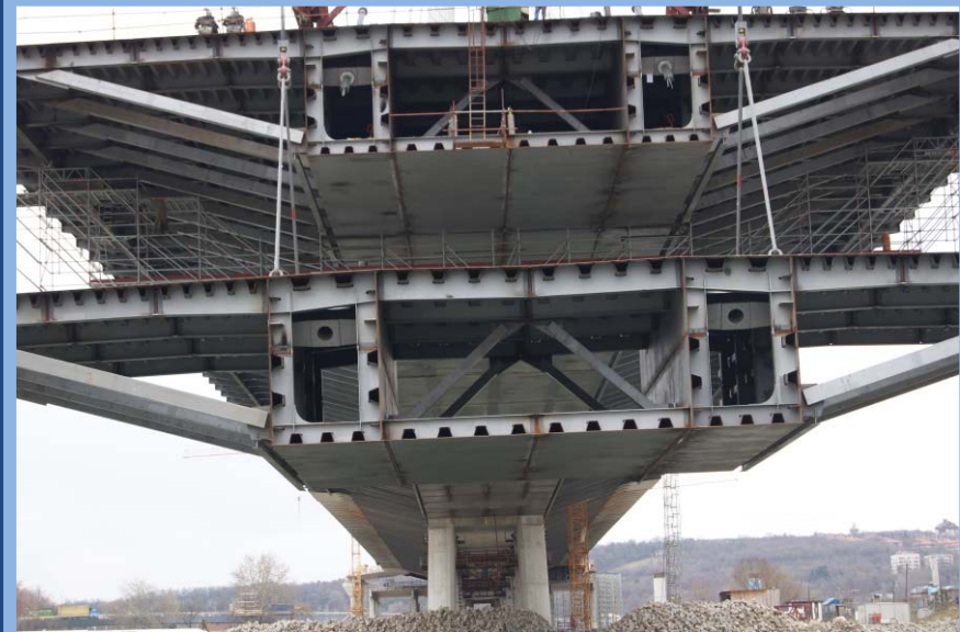
Sandučasti presjek, vrlo povoljno rasprostiranje opterećenja
