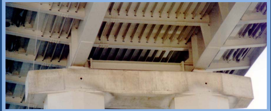
Ortotropna ploča sa zatvorenim rebrima
