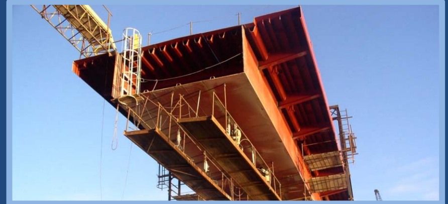
Ortotropna ploča sa zatvorenim rebrima
