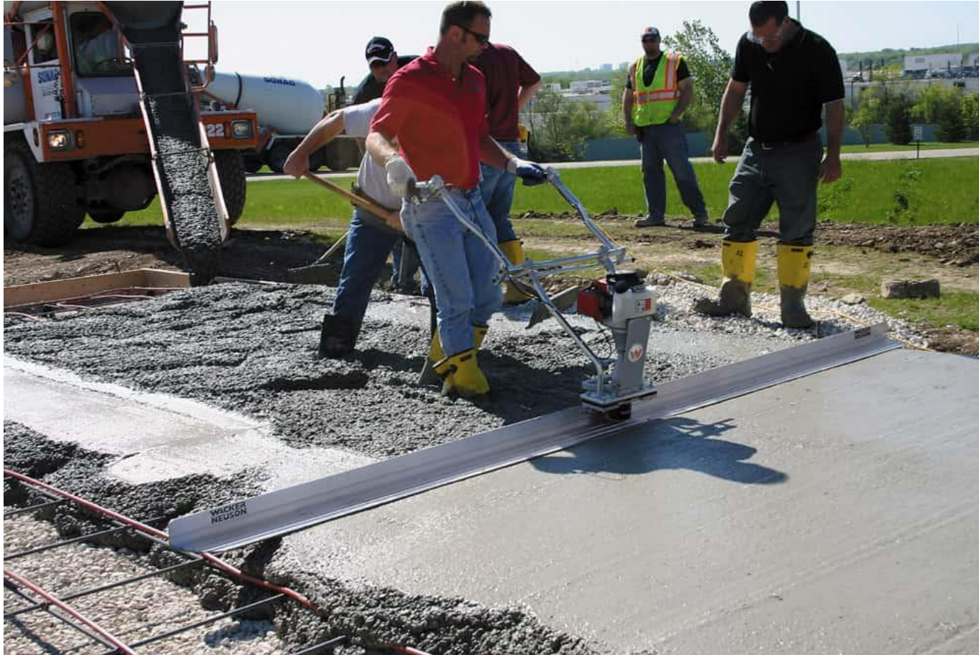
Površinski vibrator pričvrščen na dasku za ravnanje
