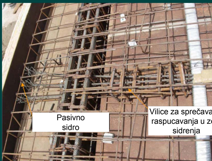
Armatura područja sidrenja na pasivnom kraju
