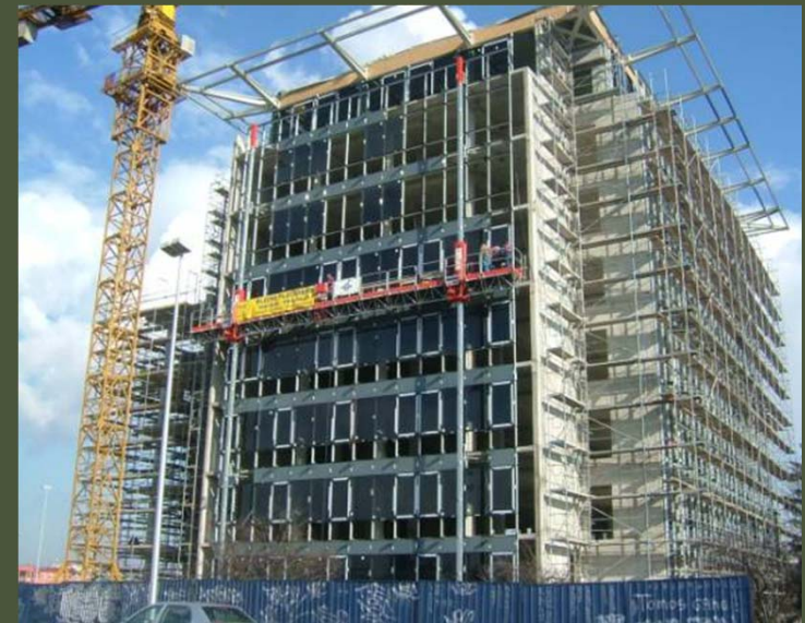
Privremene pomoćne konstrukcije pri gradnji visokogradnji: skele i platforme
