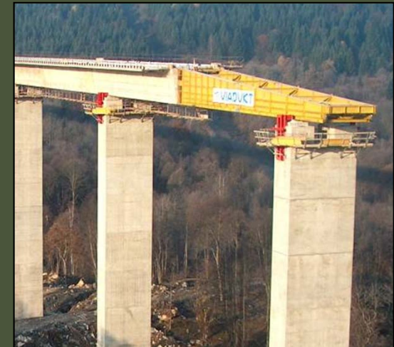
Privremene pomoćne konstrukcije pri gradnji mostova: stup, pilon, kljun
