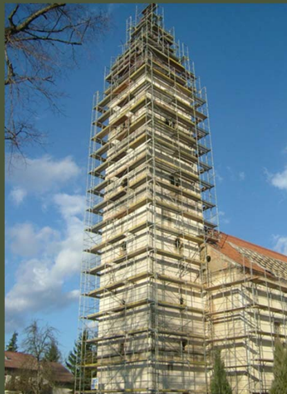
Privremene pomoćne konstrukcije pri gradnji visokogradnji: skele i platforme
