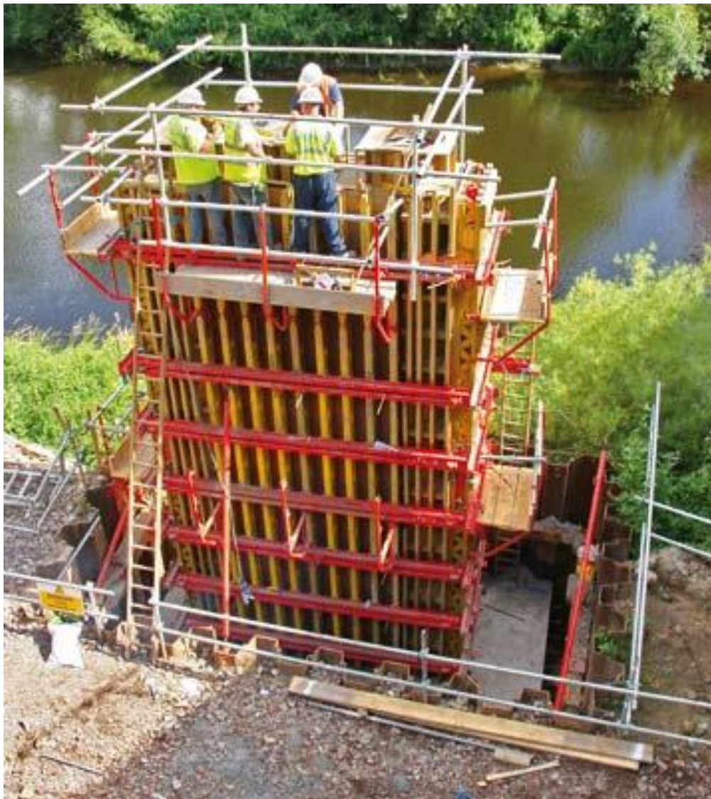
primjer sustava oplate stupa mosta
