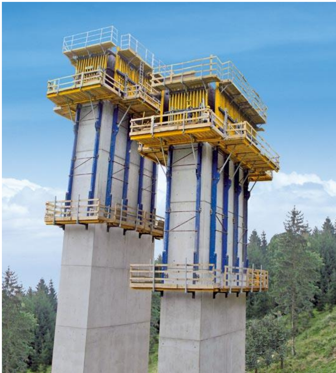
primjer sustava samopenjajuće (klizne) oplate stupa mosta
