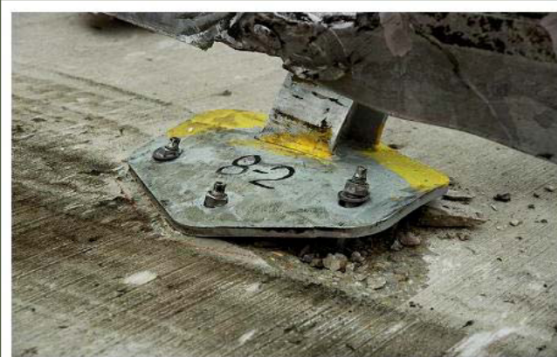
Primjeri oštećenja sidrenja zaštitnih ograda
