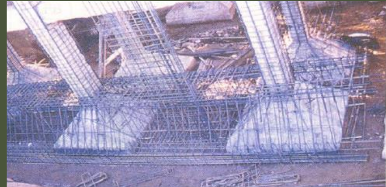
Prikaz postavljene armature za ojačanje temelja
