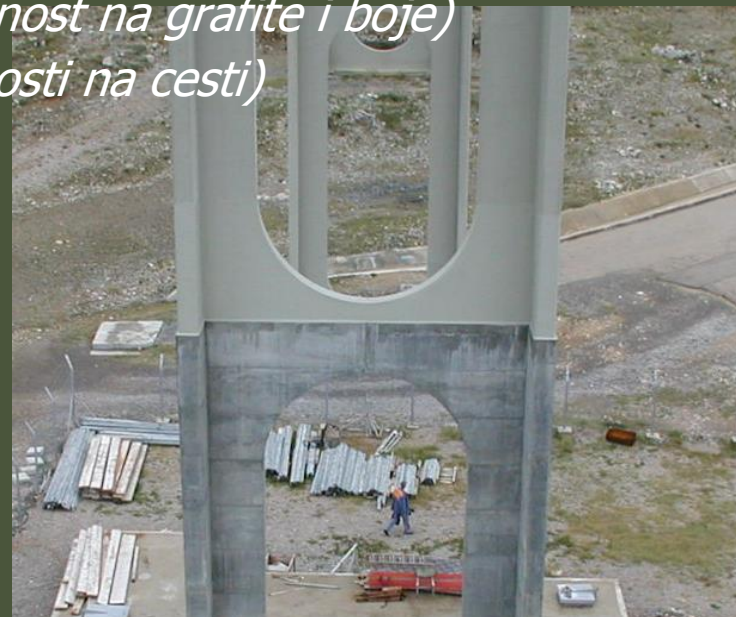
Stup malog luka Krčkog mosta, kao završna zaštita u donjem dijelu hidrofobna impregnacija, a u gornjem premaz
