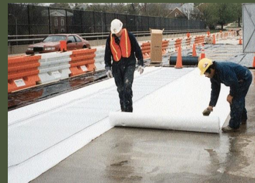
Završni sloj-sintetični filc
