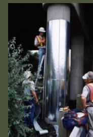
Nanošenje cinkovog hidrogela na stupove nadvožnjaka
