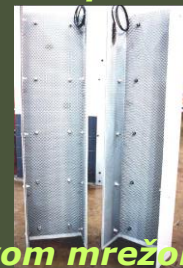
Nanošenje cinkovog hidrogela na stupove nadvožnjaka
