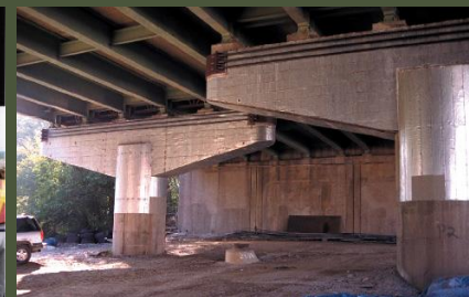
Nanošenje cinkovog hidrogela na stupove nadvožnjaka
