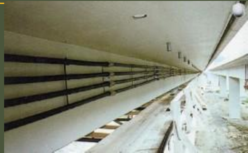
Ojačanja rasponskog sklopa prednapinjanjem vanjskih natega
