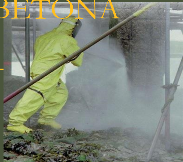
Uklanjanja oštećenog betona hidrorazaranjem
