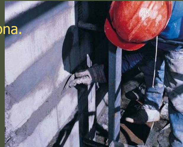
Ručna primjena morta na vertikalnoj površini
