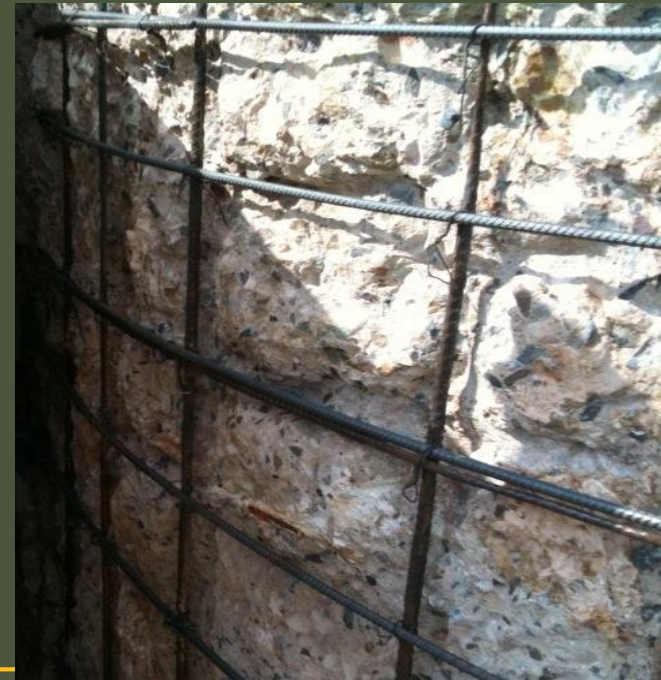
Prikaz stupa kojem je uklonjen oštećen beton
