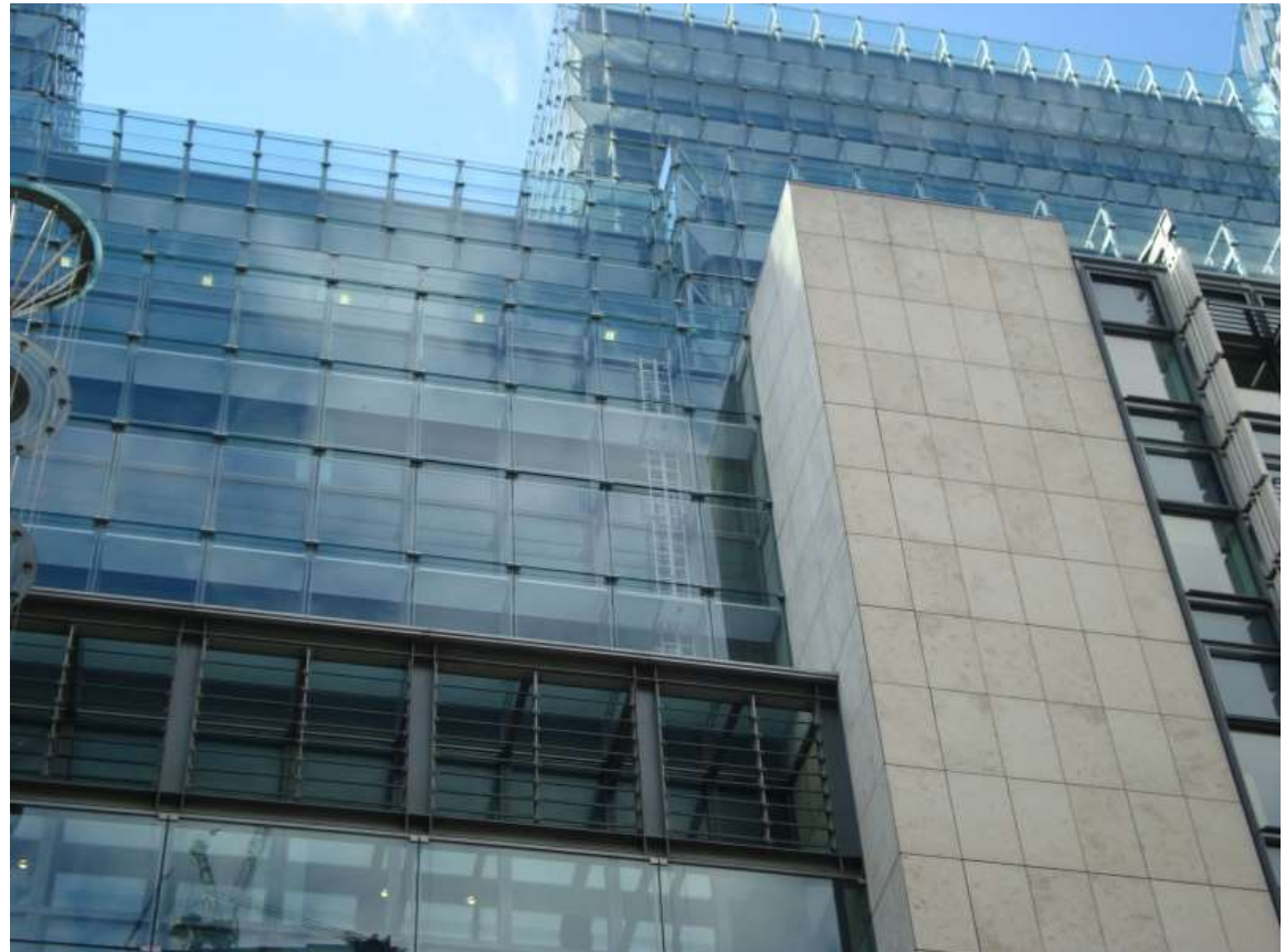
Dvostruka fasada s unutarnjim pristupnim ljestvama
