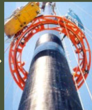
Postavljanje CFRP tkanine i protupožarnog materijala
