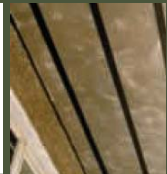
Ojačanje balkonske ploče zbog nedovoljne površine postavljene armature
