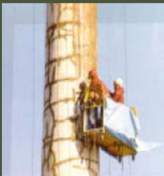
micanje ljestvi te popravak i priprema betona za postavljanje tkanine
