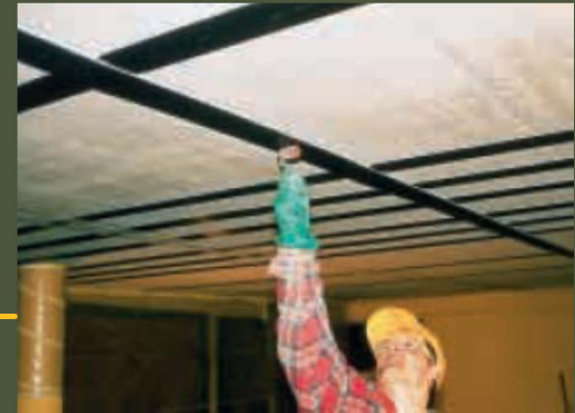
Sanacija oštećene ab stropne ploče
