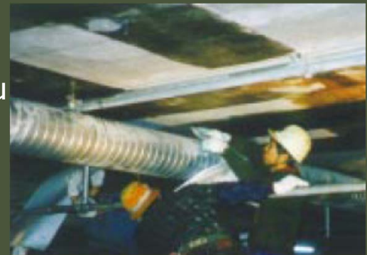
Ojačanje stropa bez micanja instalacija
