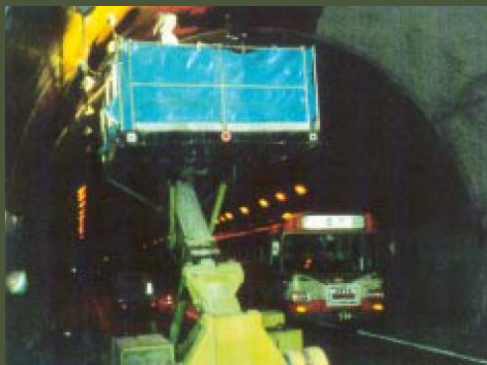
Priprema površine ispunjavanjem pukotina injektiranjem smole i brušenjem
