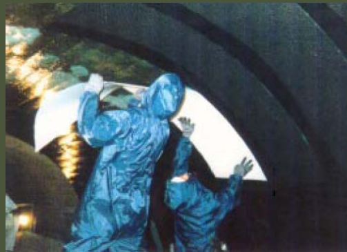
Postavljanje FRP plahti u transverzalnom smjeru uzduž luka tunela
