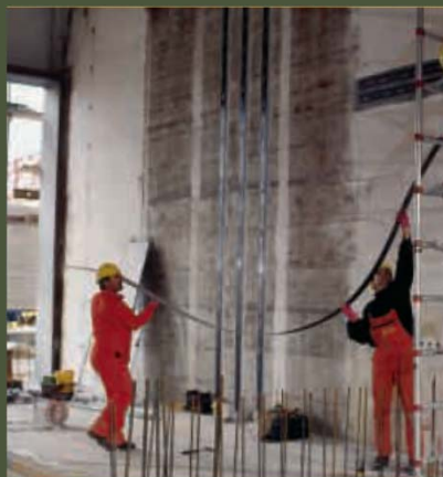
Postavljanje lamela za ojačanje zida
