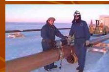
Photo Courtesy of Yalon International Radiografija zavarenih spojeva
