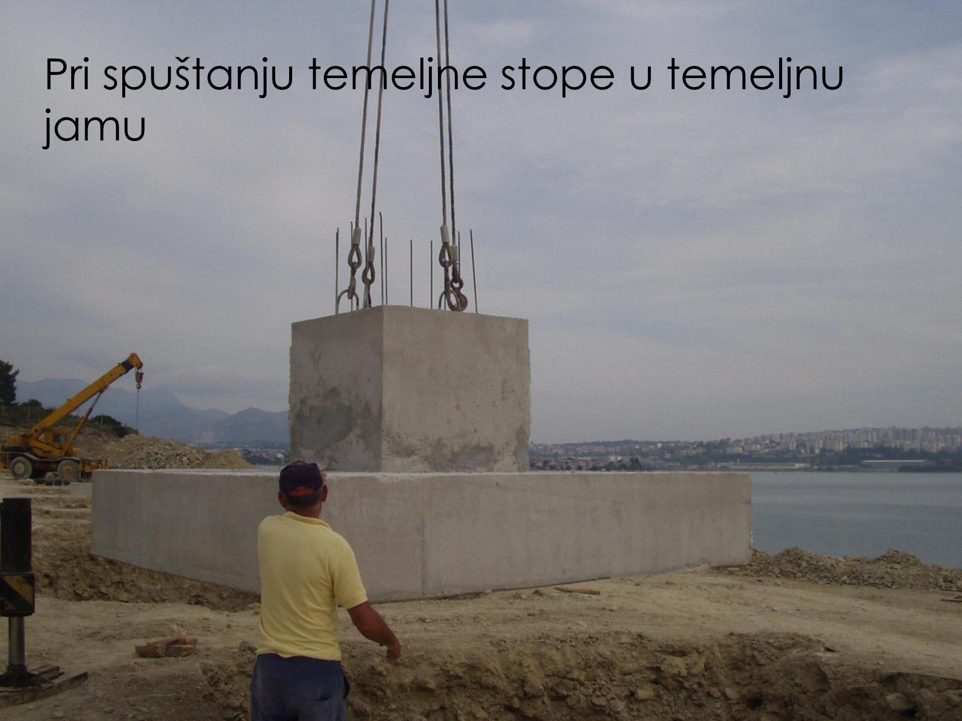
Treba biti prethodno pripremljena betonska podloga u temeljnoj jami sa označenim osima ...
